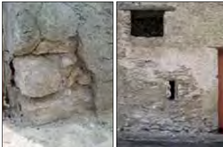
Verwendung von Gipsgestein im Mauerwerk älterer Häuser in Erpeldingen
