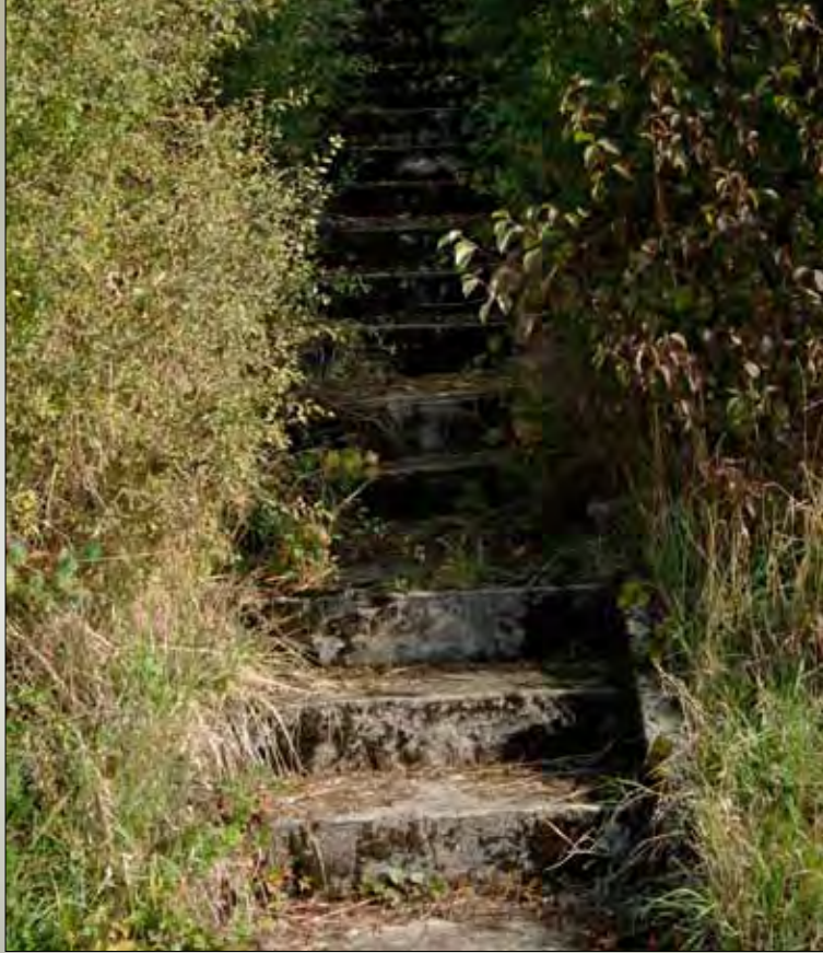
Aufgang zum ehemaligen Wärterhaus im „Bueläcker“
